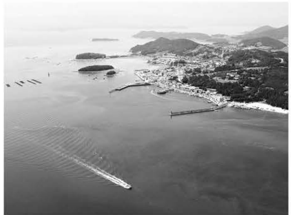
사진 9. 康津 馬良港 전경
