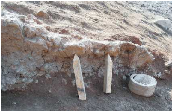
사진 34. 강진 용운리 63호 벽체 상태
