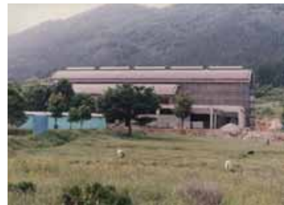
▶ 강진청자자료박물관 건축공사 모습 (1990년대 중반)
